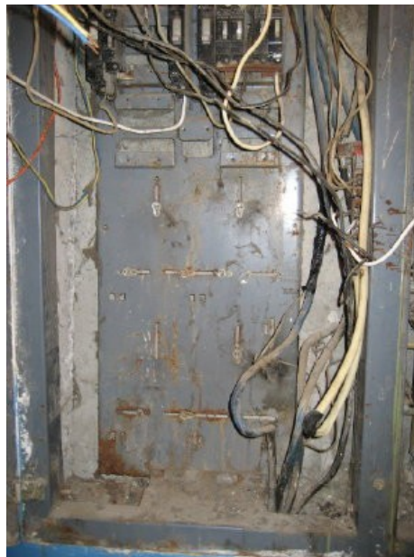
Рис 3. Через 15 минут все оборудование демонтировано и 4 квартиры обесточены.
