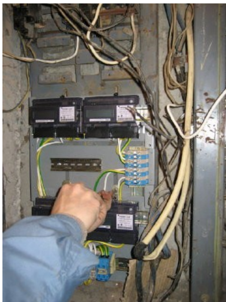
Рис 4. Начинается монтаж модуля-вкладки. Модуль поставляется уже собранным, со всей внутренней проводкой и установленными счетчиками. Модуль устанавливается на стандартные места, где раньше крепились старые индукционные
